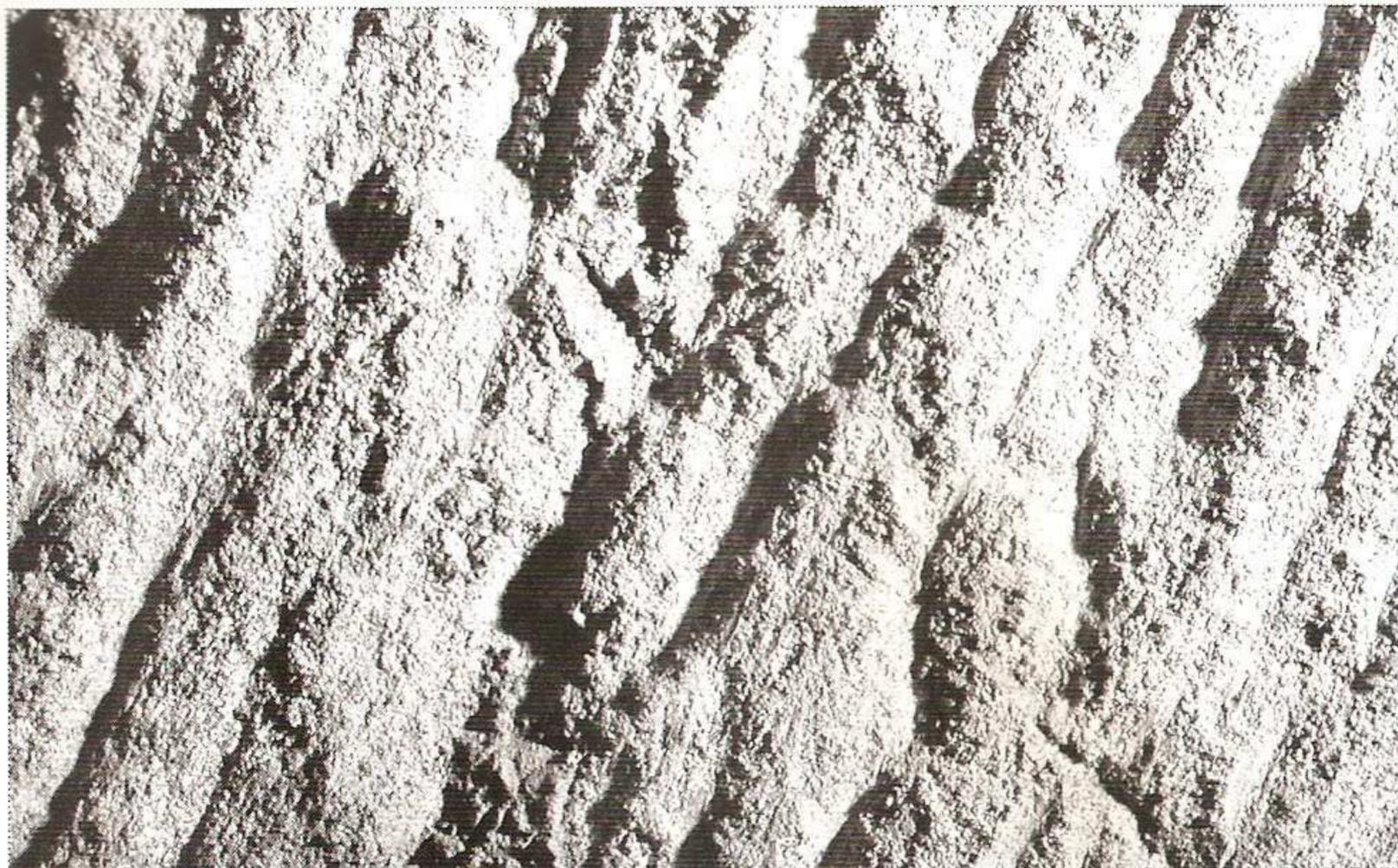
**Fig. 4** – Galería nº3 en la que son evidentes las marcas producidas por la herramienta durante su excavación.
