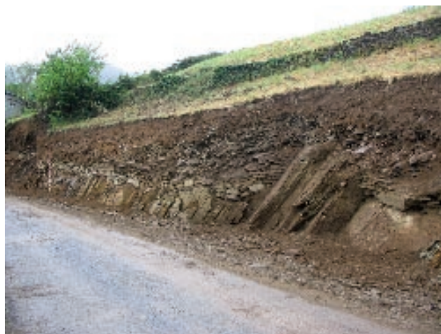
FOTO 1: Estructuras murales en la falda occidental del asentamiento. Fueron identificadas durante el control arqueológico de las obras de acondicionamiento de la carretera Taramundi-Os Teixois.
