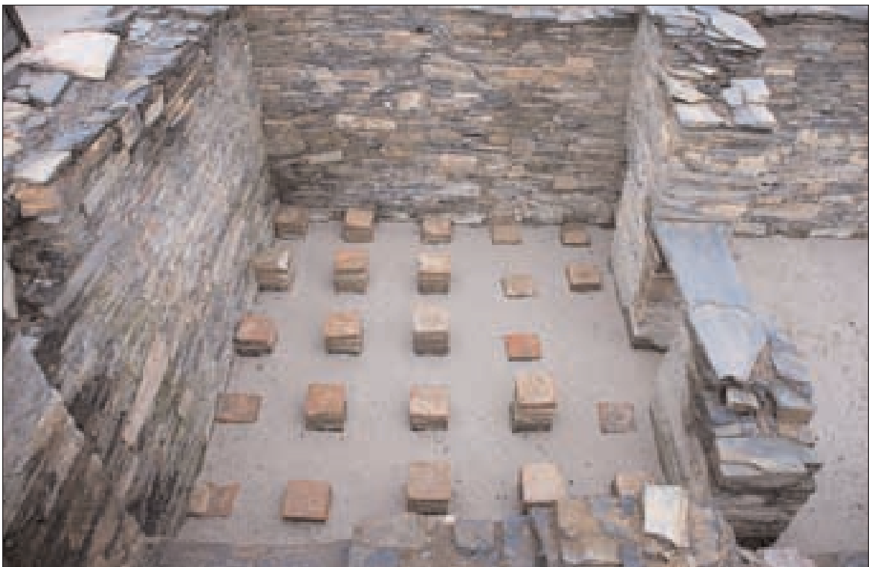
Figura 6: Estancia calefactada en el cuerpo central del edificio en el que la circulación inferior de aire caliente a través del hipocaustum se complementaba con red de tubuli embutidos entre la pared y la carga mural.
