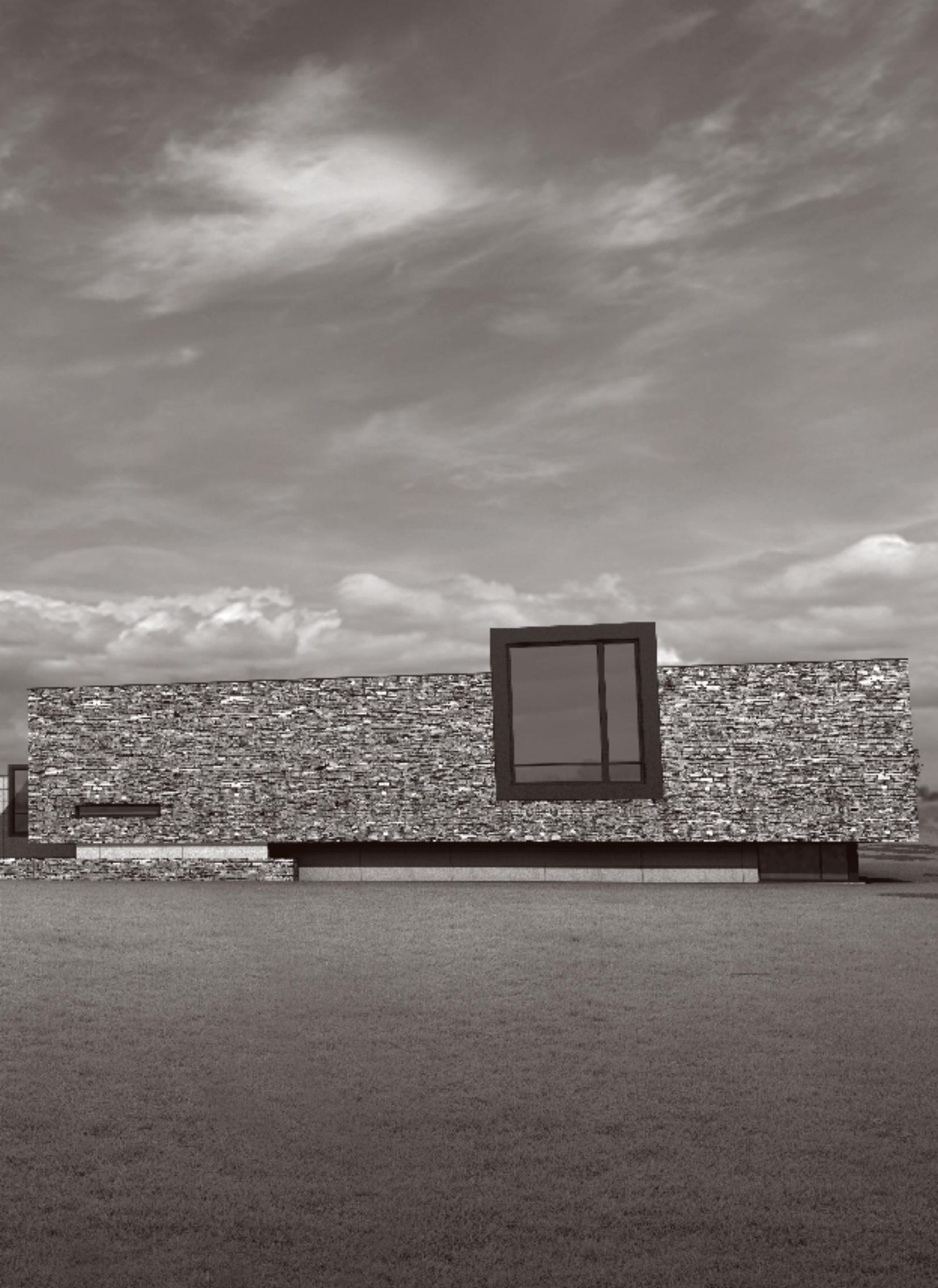
gado y pegado al terreno, siguiendo las curvas de nivel existentes, sin mucho fondo y dispuesto en dos bancadas con una pequeña diferencia de altura entre ellas. De esta manera se consigue un edificio que no es muy agresivo pero que tiene presencia y es una referencia clara en el valle.
