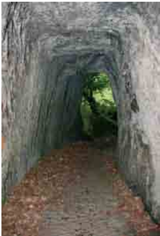
Fig 6. Tramo subterráneo del canal que abastecía la mina de Valabilleiro a su paso por el lugar de Penafurada (Grandas de Salime).
