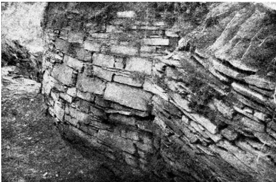
Fig. 28.- Aparejo de una de las cabañas del castro (la reproducida en la fig. 5) (Fotos Buelta).
