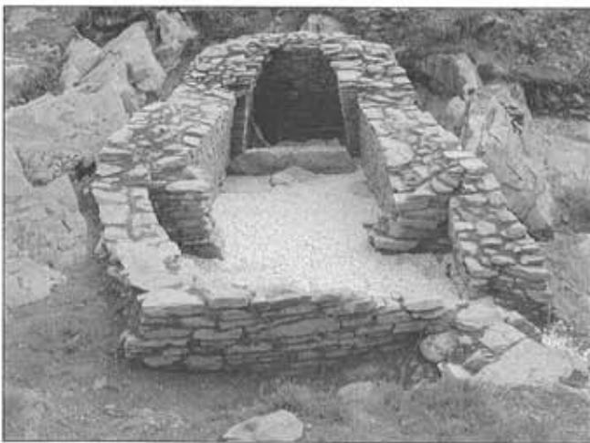
Figura 9.—Pendia 2. Aspecto tras la consolidación con la cual el equipo de restauradores afrontó la reintegración de los paramentos amputados y los problemas de encharcamiento originados por la potencia de las rebuscas clandestinas.
