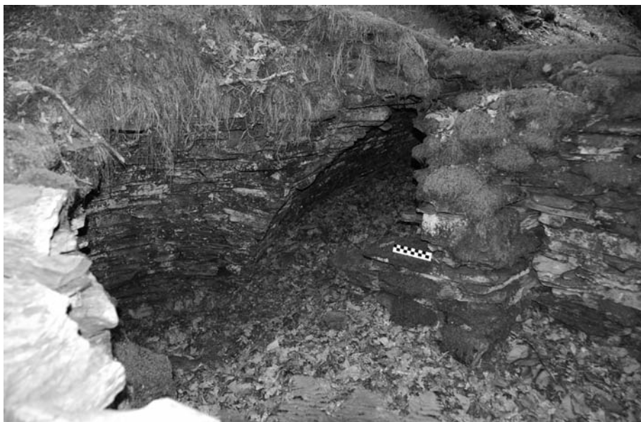
Fig. 6. Castro de Castelo o Castelón, en Castañoso (Lugo). Encuentro de la cabecera con la cámara principal, ambas rematadas en falsa bóveda por aproximación de hiladas.
