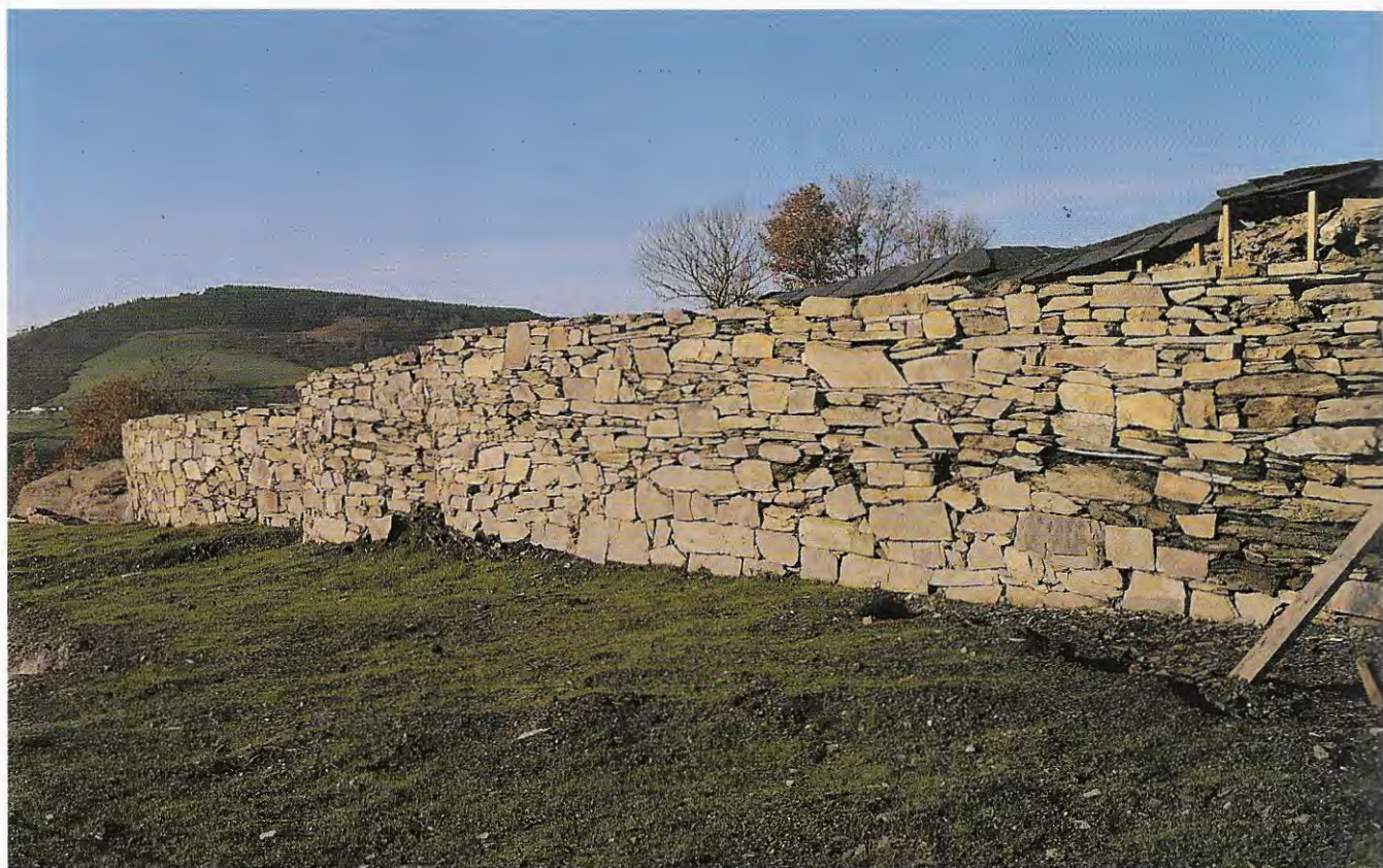
Les muralles del Chao Samartín conseñen una llarga hestoria de reformes. Construyíes clásique d'afechu con cuarcites, la so estructura respunde al sistema de módulos
