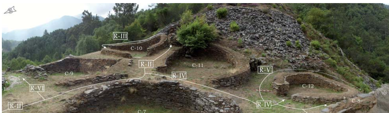
Fig. 4. Panorámica del caserío principal con la red de comunicación entre construcciones.
