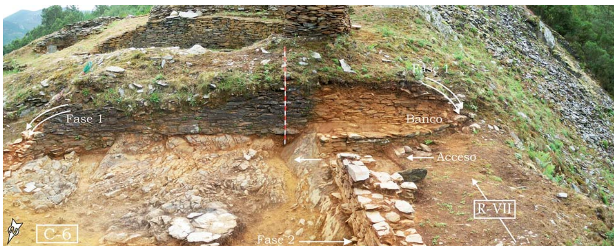
Fig. 10. Representación de las dos fases constructivas de C-6, junto con la calle R-VII y el espacio aledaño a la entrada. R-VII ocupa en esta zona un área de unos 20 m 2 .
